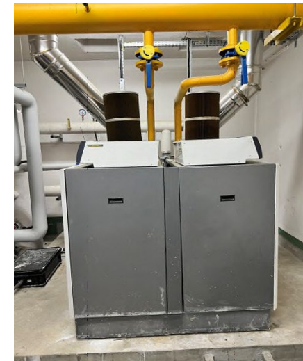
Chaudières gaz à condensation DE DIETRICH C610 – Pu = 350 kW
